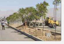
کارگاه کاشت درخت
