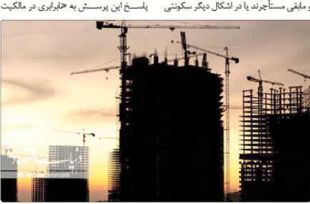
مشروع ساختمانی در حال اجرا در یک شهر.
