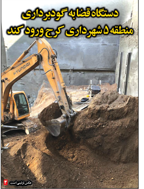
دستگاه قضا به گودبرداری منطقه ۵ شهرداری کرج ورود کند عکس تزئینی است
