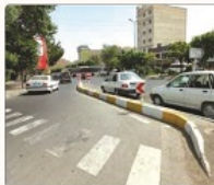
نمای کلی از عملیات ساماندهی نیوجرسی‌های بنی در یکی از معابر شهر کرج.
