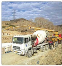
عملیات عایق‌بندی آبگیر دوم دهکده تفریحی باغستان در حال انجام است.
