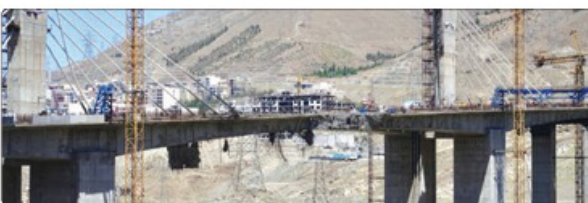
این جنایات همچنان با جدیت ادامه خواهد داشت. اعضای این کاروان رسانه‌ای نیز ضمن ستایش همت و شهرداری کرج در طراحی و ساخت این پل با ویژگی‌های خاص فنی و مهندسی و همچنین وعده
