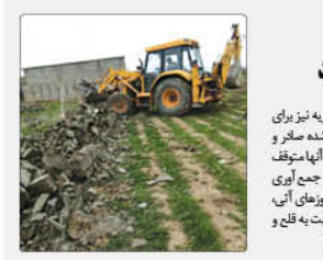
ساخت و سازهای عمرانی در شهرک صنعتی سپهر شهرستان نظرآباد
