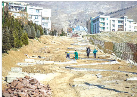
رئیس سازمان سیما، منظر و فضای سبز شهری شهرداری کرج در حال بازدید از سایت ساخت پارک در کلاشگری کرج در حال بهره‌برداری خواهد شد.
